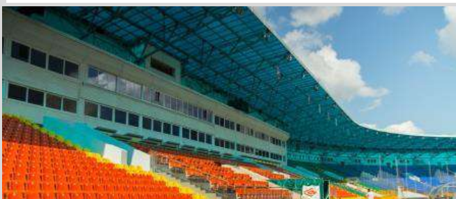
Кровля футбольного стадиона, г. Казань
