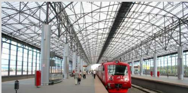
Кровля вокзала аэроэкспресса Шереметьево
