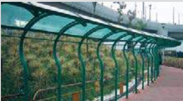
Навес над остановкой ж\д транспорта в Гонконге. Применялся 6 мм зеленый лист монолитного поликарбоната.
